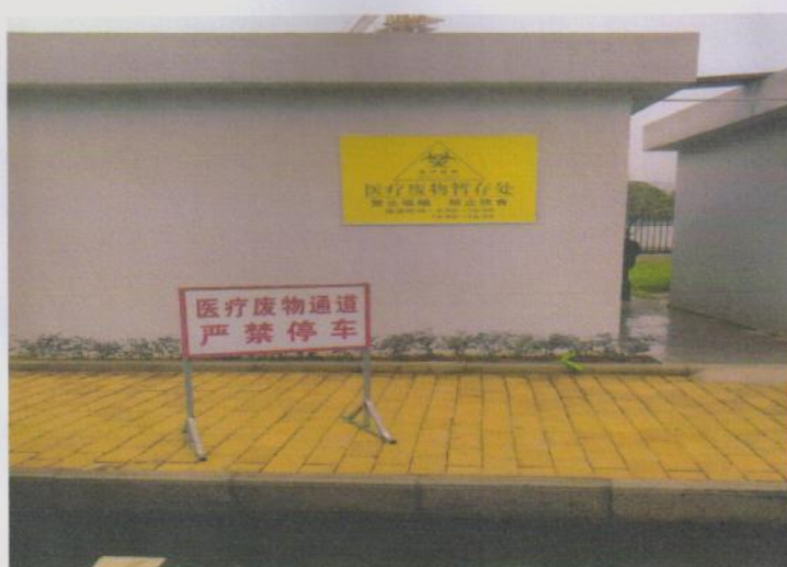
图 4-4 医疗废物暂存间
